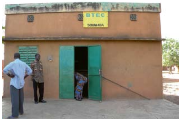
Les caisses des BTEC sont installées au cœur des villages
